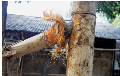
写真 3-24 冷却管との接合部分を密封する。
