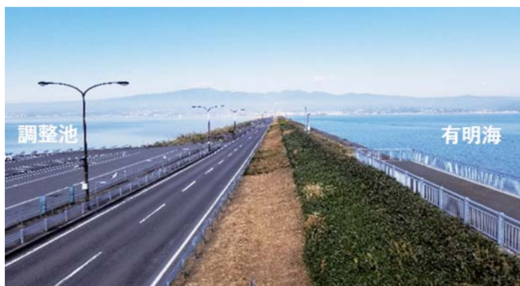
写真2 諫早湾干拓堤防道路
