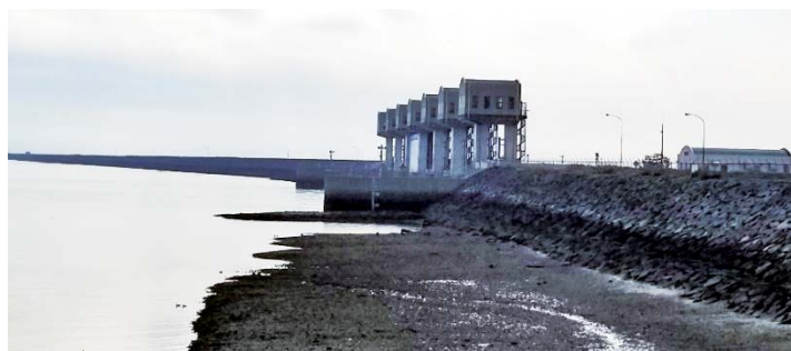
写真1 諫早湾潮受け堤防の北部排水門
