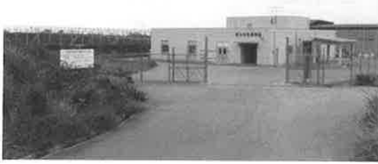
写真5 竹富町リサイクルセンター (2009年9月撮影) 注：写真左手から最終処分場、浸出水処理施設、リサイクル施設である。
