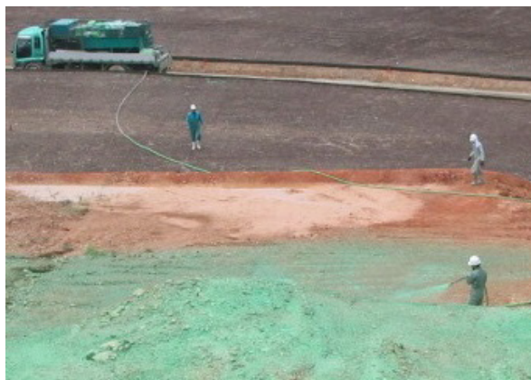
図1 工事現場での土壌団粒化剤散布の例
